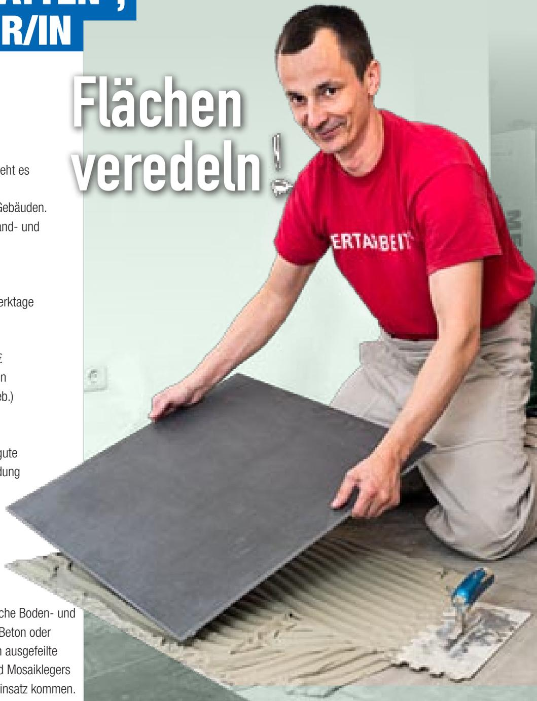
aufeinander abgestimmt werden. Dann erst geht die eigentliche Handarbeit los: die Herstellung von Ansetz- oder Verlegemörtel, der eine feste Verbindung zum Untergrund schafft. Und der Zuschnitt des zu verlegenden Materials mit entsprechenden Schneidegeräten, Trocken- und Nassschneide- sowie Abfass- und Abkantmaschinen, die für eine saubere Maßarbeit notwendig sind.
